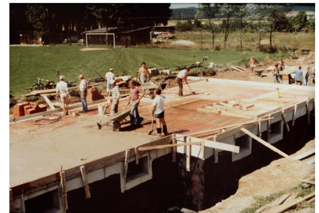
Die Kellerdecke wird betoniert, im Hintergrund die Baumschule und links oben die Hütte mit den damaligen Umkleiden
